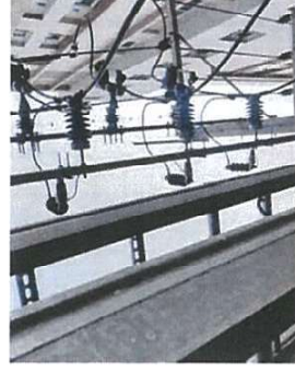
อุปกรณ์ป้องกันสายแรงสูง : Lightning Arrester
