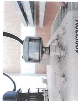
เทอร์มิสแตอร์วัดอุณหภูมิของน้ำมัน : Oil Temp
