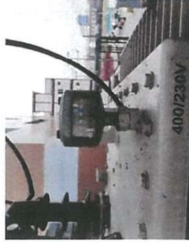
เทอร์มิสเตอร์วัดอุณหภูมิของน้ำมัน: Oil Temp
