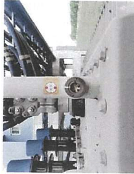
ตัววัดระดับน้ำมัน : Oil level Indicator
