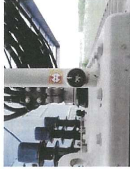
ที่วัดระดับน้ำมัน: Oil Level Indicator
